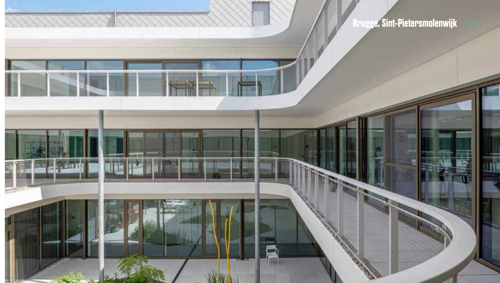
Bewoners genieten door de beglaasde binnenpatio's van de buitenlucht in de beste omstandigheden, met voldoende licht en beschut tegen weer en wind.
